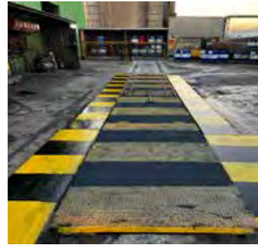
Bakım kanalının üzeri, raylı sistem ile açılıp kapanmaya uygun şekilde kapatılmıştır.
